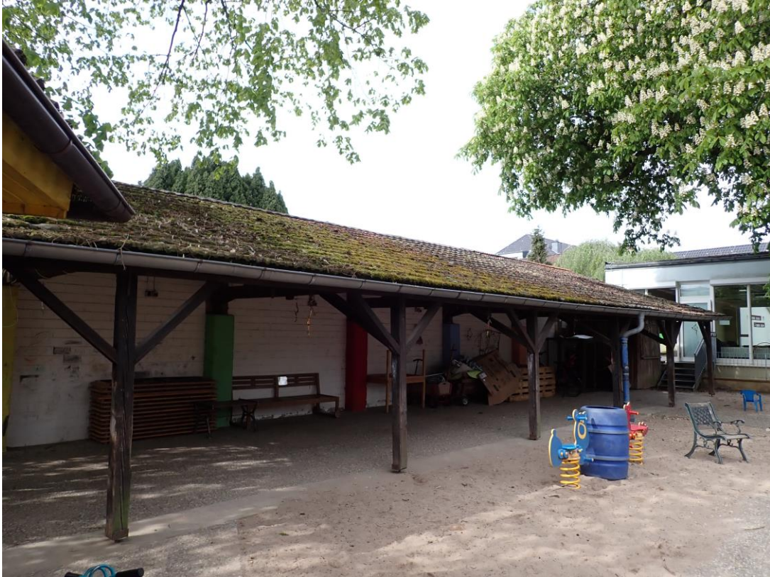
Abb. 12: Vorbau mit potenziellen Nischen z.B. für den Hausrotschwanz
