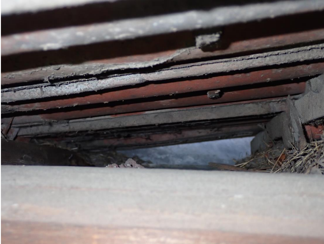
Abb. 8: Ortgang/Mauerkrone als Brutplatzbereich vom Haussperling.
